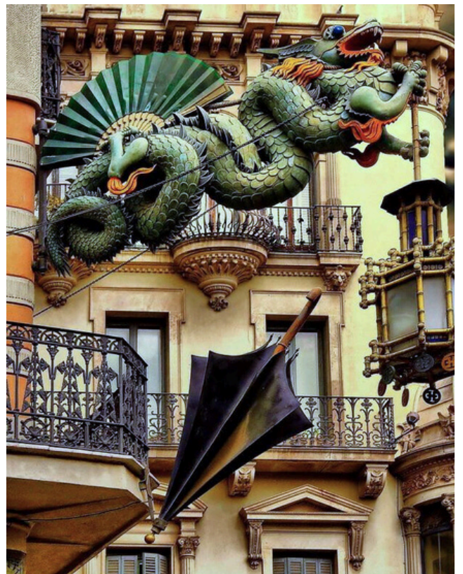
Fachada de la Casa Bruno Cuadros, de Josep Vilaseca, en Barcelona
